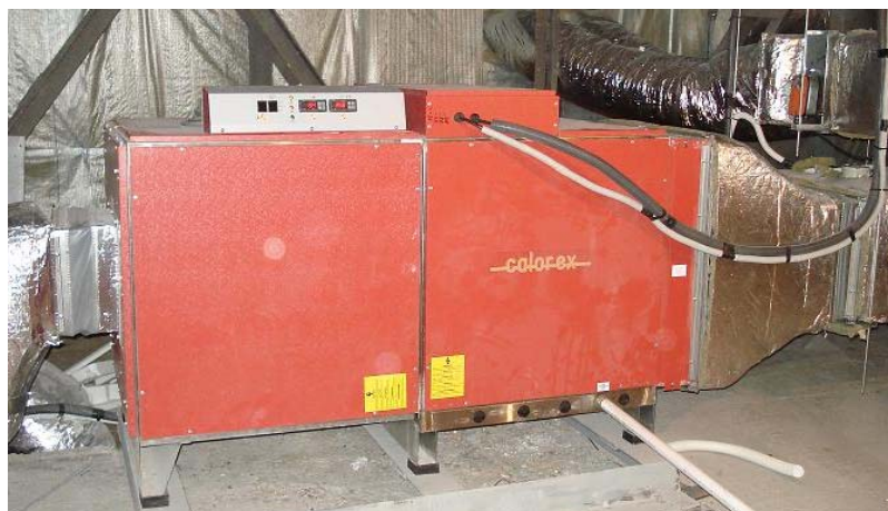
Пример установки канальной системы осушения CALOREX VARIHEAT III
